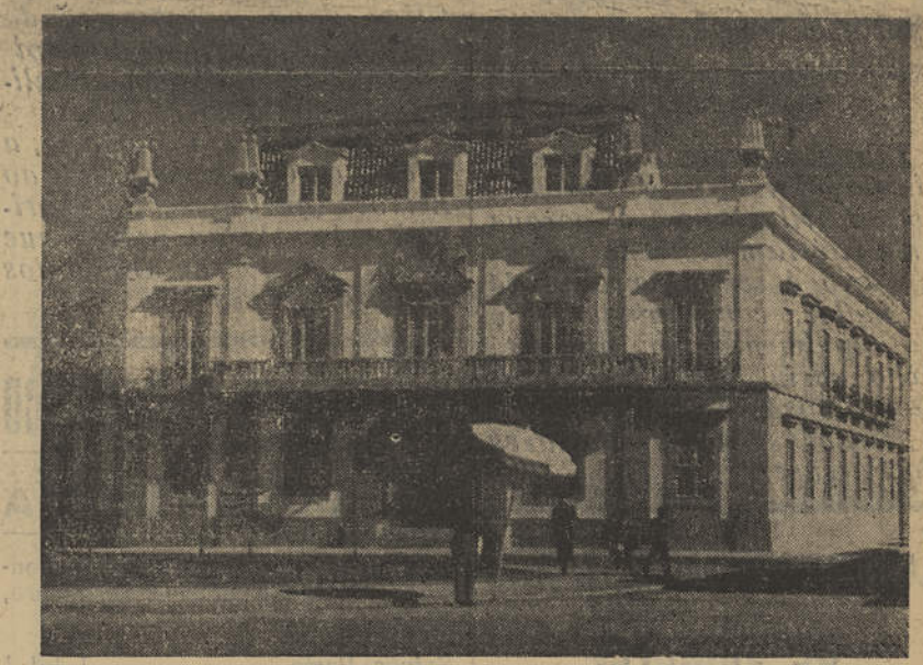
A fachada principal da Junta Distrital de Faro
