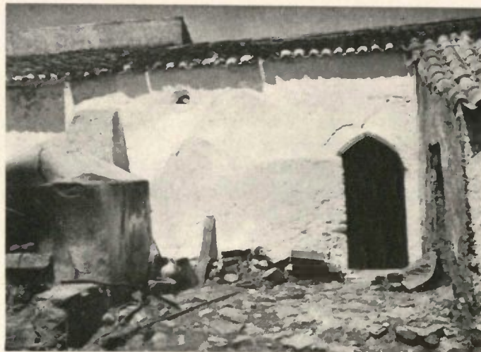
O corpo direito do mesmo edifício, onde se vê a porta gótica simples. (Para a esquerda desta porta vê-se ainda o vestígio duma porta idêntica que foi entaipada, e mais para a esquerda um contraforte, por detrás do forno actual).
