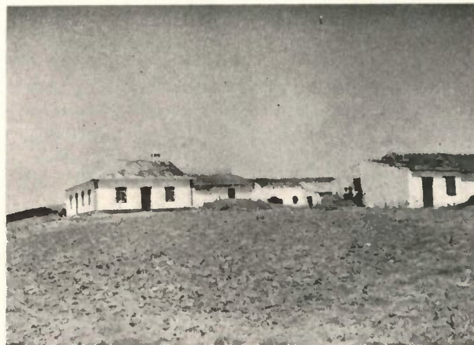
RAPOSEIRA (Quinta) — Vista geral. O prédio novo (à esquerda) foi construído no sítio doutro, arruinado mas que tinha «arcos à romana» (ogivas), segundo a informação do actual proprietário e dos vizinhos.
