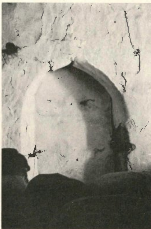
Areo ogival duma porta de comunicação na parede do fundo (à direita, entrando-se na casa pela porta da fig. 7)
