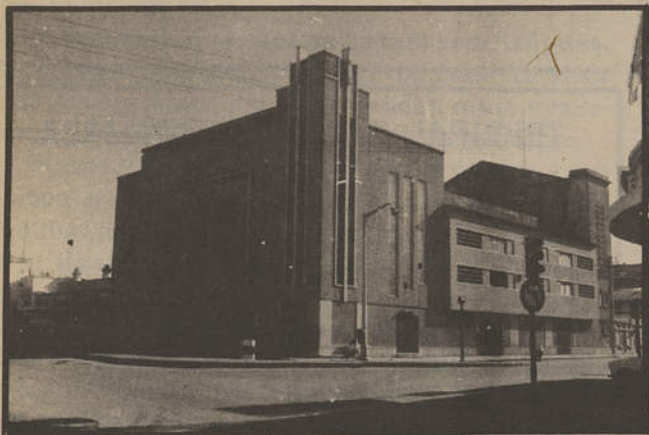
O VELHO CINE-TEATRO JÁ DEMOLIDO, INAUGURADO EM 1938
