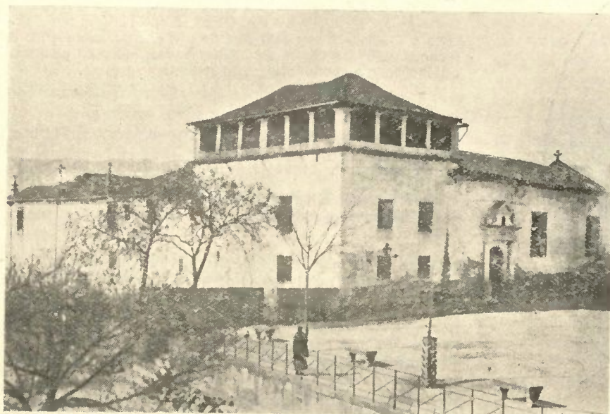
VILA REAL—O velho Convento de Santa Clara, que está sendo demolido
