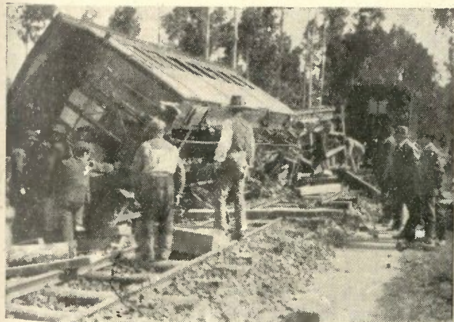
4- Um dos vagons descarrilados
