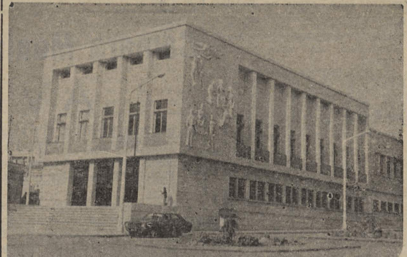
Imagem de um moderno edifício da cidade de Faro (o do Palácio da Justiça), cidade onde o contínuo crescimento da Feira de Santa Iria poderá em breve aconselhar medidas diferentes na respectiva orientação.
