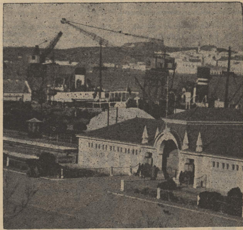
Um aspecto do porto de Vila Real de Santo António, a que se espera as anunciadas obras da nova barra venham insuflar actividade mais condizente com a importância das suas instalações.
