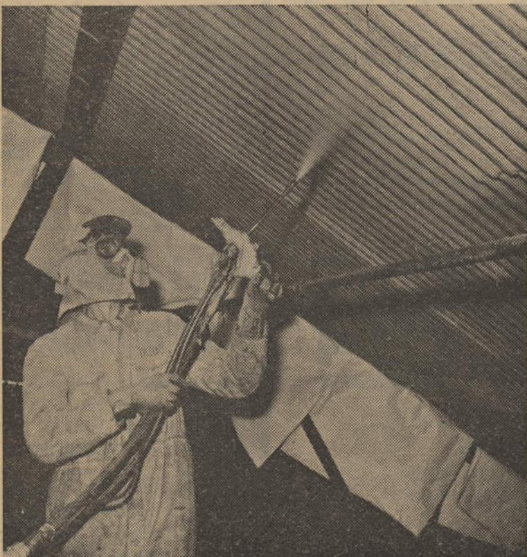
Pulverização de espuma de poliuretano no forro de um telhado
