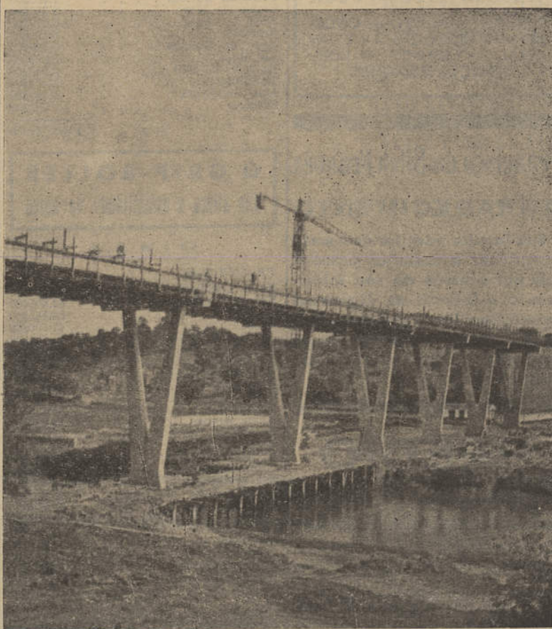
A ponte sobre o rio Gilão, em Tavira, que evita duas passagens de nível na estrada principal do Algarve
