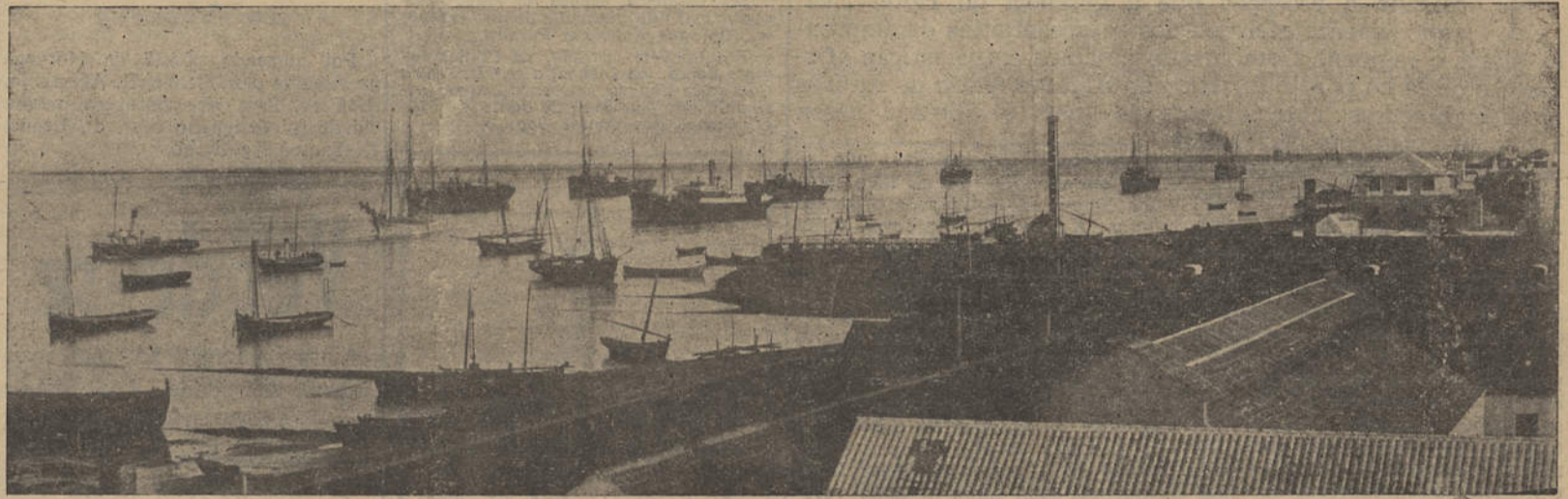
Depois do Tejo e do Sado, o maior estuário dos rios portugueses é o do Guadiana. Nele podem ancorar e movimentarem-se dezenas de navios de alto bordo, oferecendo todas as condições naturais e sem encargos fabulosos para continuar a ser um grande porto. Nesta foto, tomada no primeiro quartel do século actual, vemos ancorados sete navios de alto bordo a aguardar a sua carga de minério
