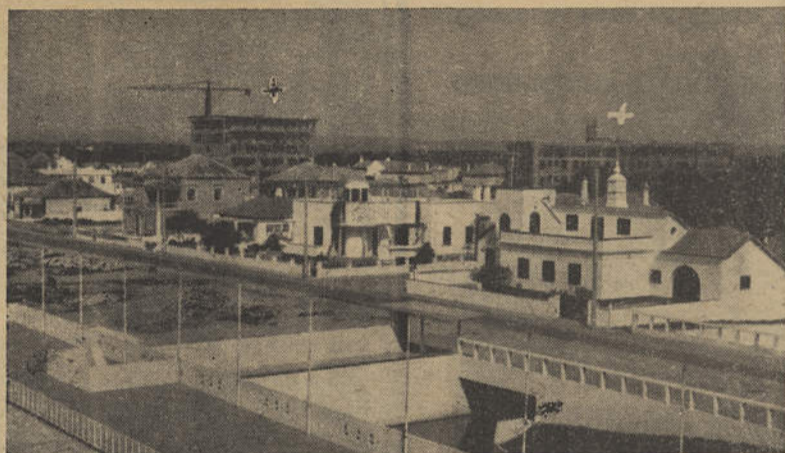
Os hotéis em construção em Monte Gordo: à esquerda o Hotel das Caravelas e à direita a Estalagem dos Navegadores. Foto tomada do Hotel Vasco da Gama
