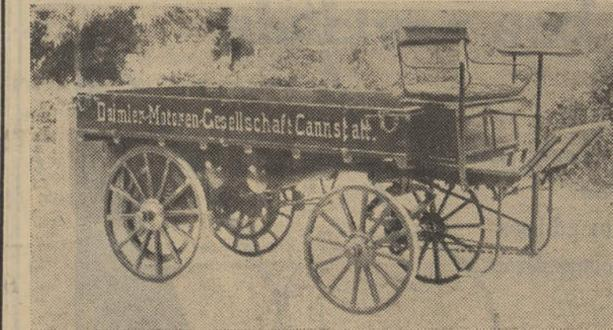
O primeiro camião construído pela fábrica que daria nascimento à marca MERCEDES-BENZ possuía um pequeno motor de 4 HP que imprimia uma velocidade máxima de 10 Km. ao veículo, com a sua carga máxima de 1.500 Kgs.
