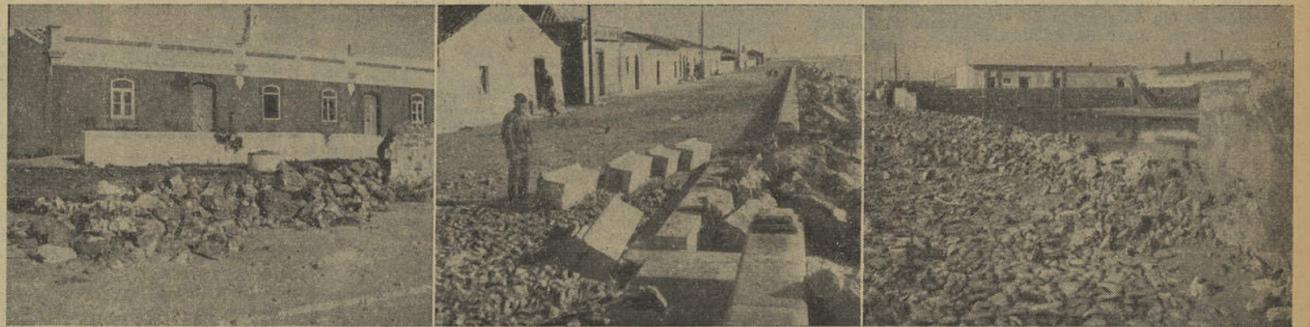
Três aspectos da acção devastadora do mar na povoação de Cabanas: 1—Destruído o muro de defesa, a casa do sr. Jerónimo Neto encontra-se à mercê das vagas. 2—Um lanço da muralha construída no ano findo, ruíu já, apesar do enrocamento que a protege. 3—Outro muro destruído em grande extensão permite o avanço das águas e põe em iminente perigo as casas vizinhas.
