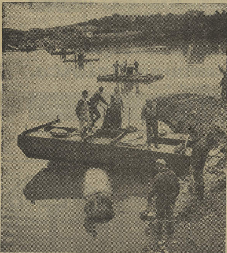
Colocando um «pipe-line» sob um rio para depois prosseguir a sua rota terrestre
