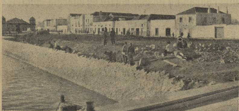
Aspecto dos trabalhos de enrocamento marginal junto à doca de Olhão
