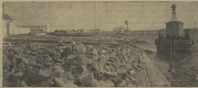
A draga-escavadora procedendo aos trabalhos de regularização da Ria Formosa
