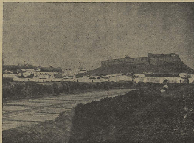
O castelo de Castro Marim que tem sofrido obras de beneficiação e cujo aproveitamento assistencial devia ser encarado
