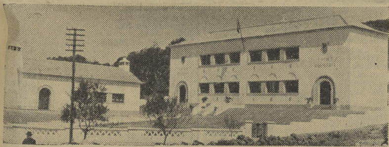
Os novos edifícios da escola e da cantina de S. Bartolomeu de Messines
