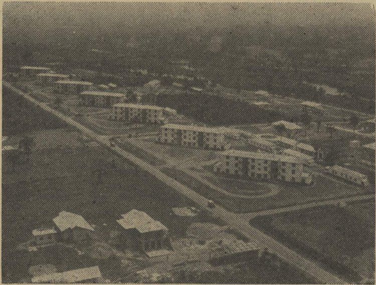
Blocos de edifícios, construídos em Port Harcourt (Nigéria), para residência do pessoal da Shell que trabalha naquela longínqua área.
