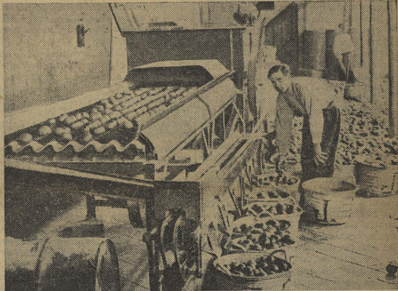
Máquina seleccionadora de laranjas trabalhando num armazém de Vátencia
