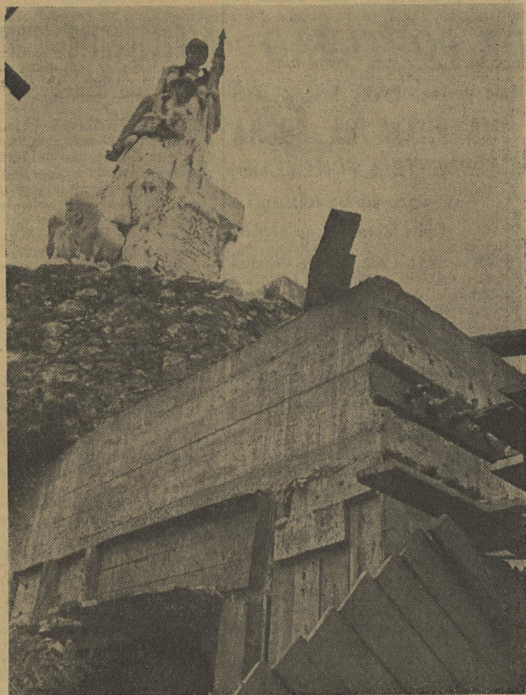
SUSPENSÃO DO MONUMENTO AOS MORTOS DA GRANDE GUERRA USANDO AÇO MACALLOY
