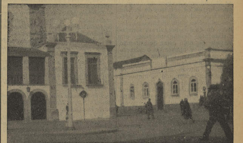
À direita, o velho edifício dos C. T. T. de Olhão, cuja substituição, por insuficiente, a importante vila há muito solicita
