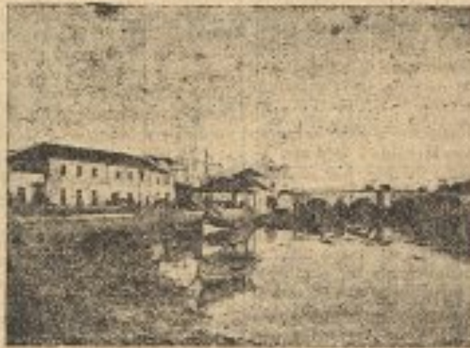
SILVES—Ponte e cais
