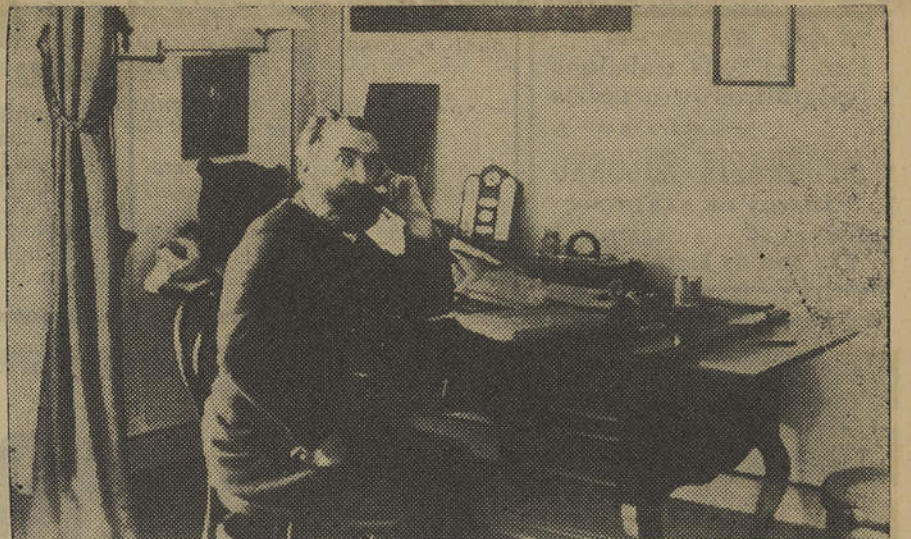
João de Deus no seu gabinete de trabalho (fotografia tirada por ocasião da apoteose de que foi alvo)
