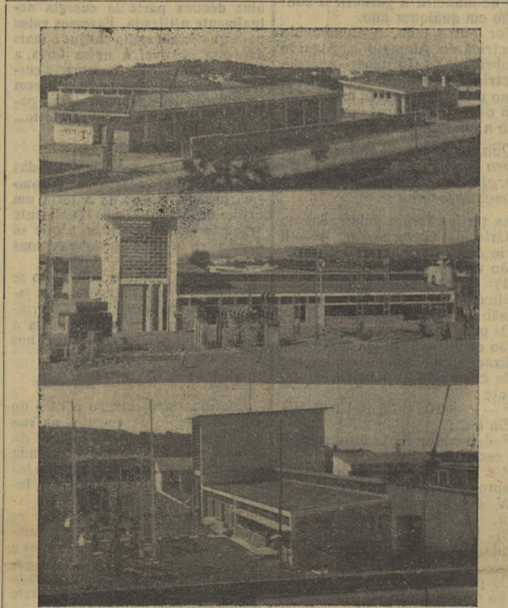
Três aspectos das modernas instalações da Subestação de Loulé da C. E. A. L., que abrangem uma área de 15.000 metros quadrados
