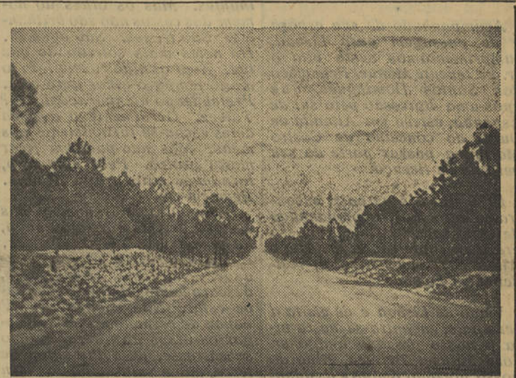
Estrada através da Mata Nacional onde se projecta instalar o Parque de Campismo
