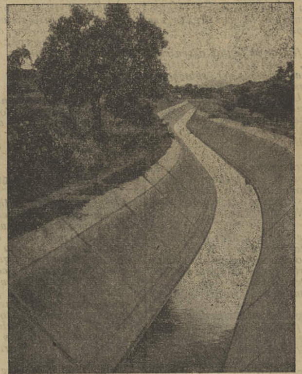
Um trecho do Canal da Conduta Geral de Silves
