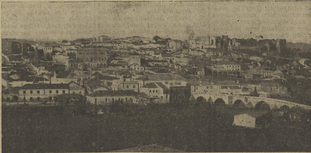
Vista parcial da cidade de Silves, em cujos arredores se inaugura no próximo domingo a Barragem do Arade, a primeira obra no género que se constroeu no Algarve
