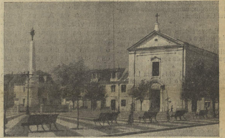
Praça Marquês de Pombal Formoso exemplar da arquitectura pombalina
