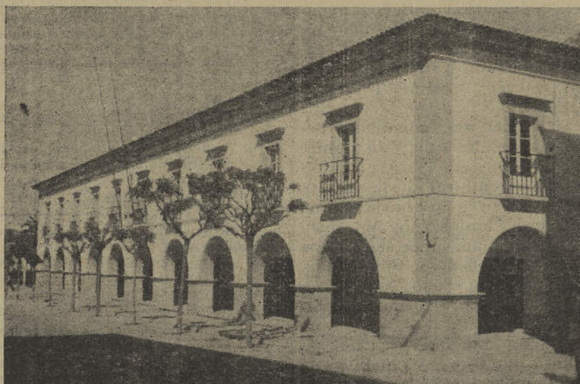
O Moderno Edifício dos Paços do Concelho, cérebro da vida local
