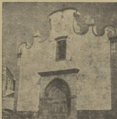
Fachada da Igreja de Conceição de Tavira
