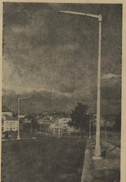
Colunas «CAVAN» 8,80 m. total, 7,50 m. fora do solo, com braço simples para luz fluorescente colocadas em Vizeu
