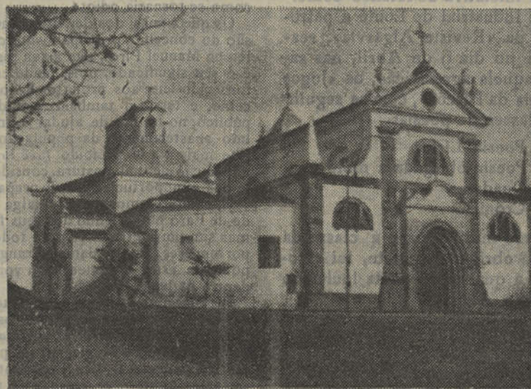
Igreja de Santa Maria do Castelo, onde se realizam as cerimónias da Semana Santa
