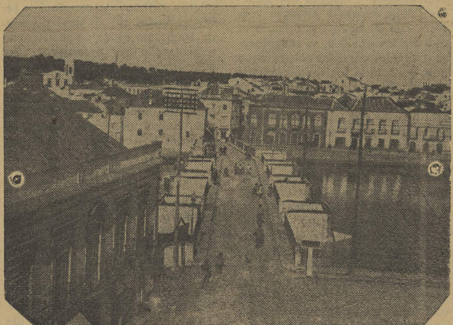
TAVIRA — Ponte Romana sobre o Gilão
