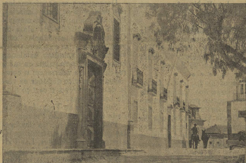
Hospital da Santa Casa da Misericórdia de Tavira
