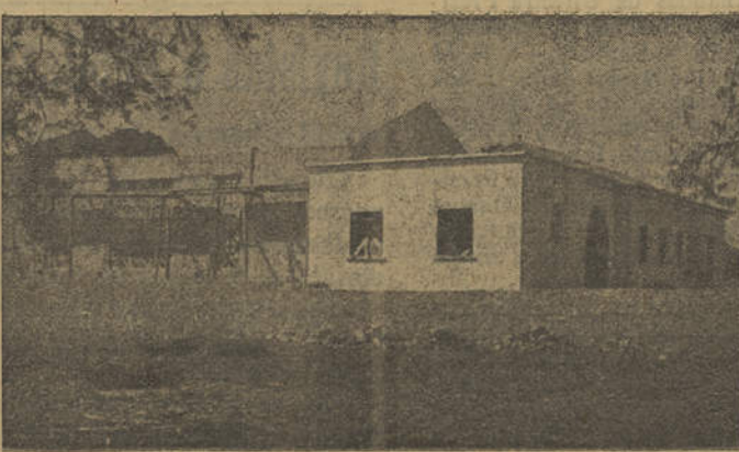
Novo edifício da Casa do Povo da Luz de Tavira, quase concluído
