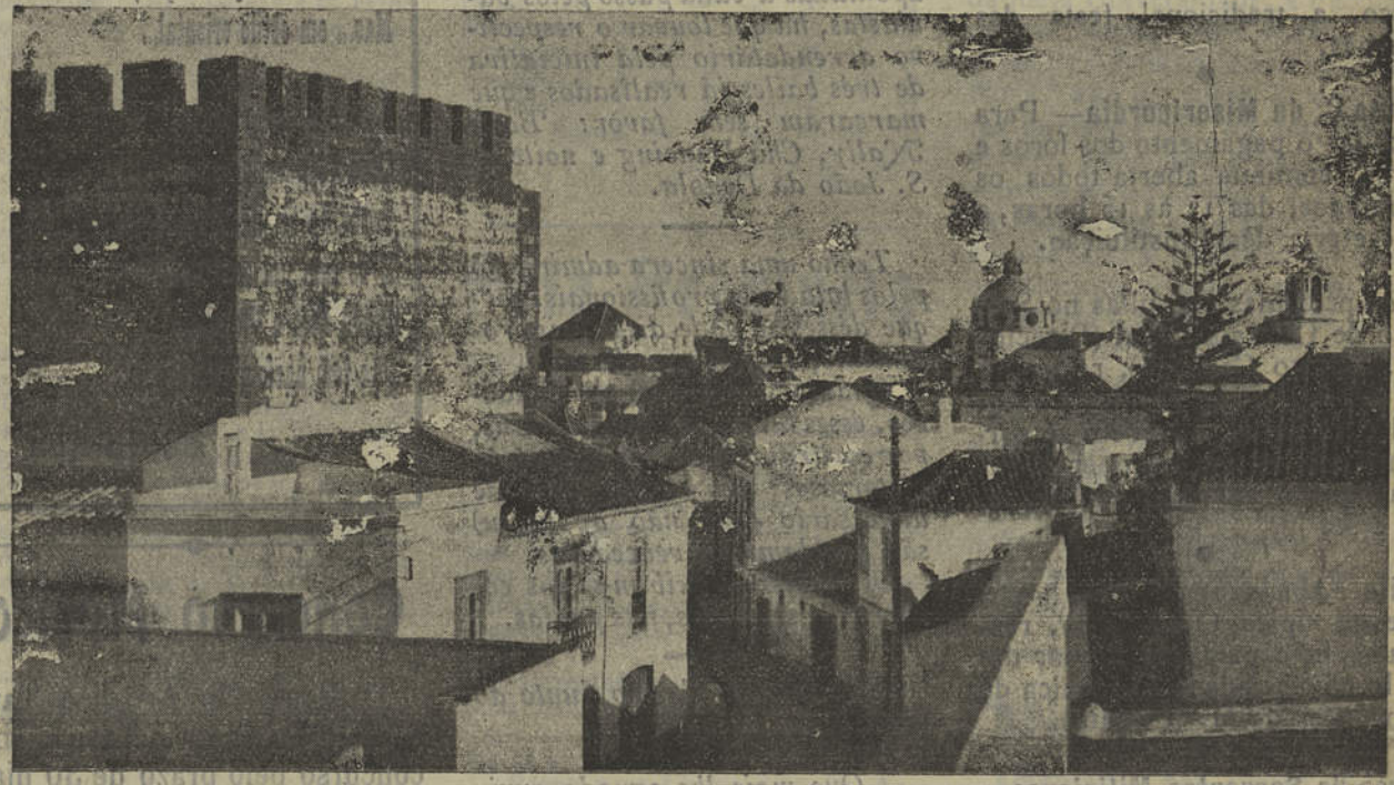
Tavira — Rua dos Mouros e aspecto duma muralha
